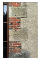
Différents appareillages de briques, droits et en harpage*, en association avec de la pierre.
