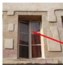
Surépaisseur et irrégularité des encadrements ou chaînages
