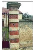
Différents appareillages de briques, droits et en harpage*, en association avec de la pierre.
