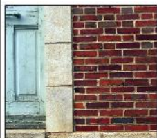
Différents appareillages de briques, droits et en harpage*, en association avec de la pierre.
