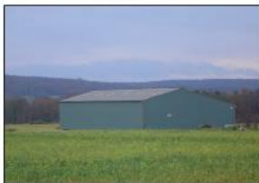
Bardage en tôle grise.
